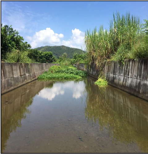
护岸工程现状
