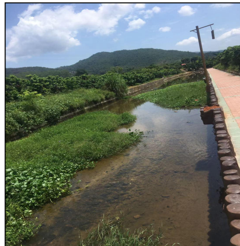
护岸工程现状
