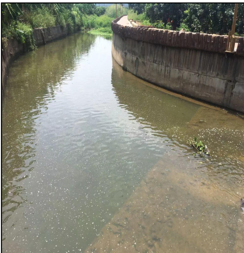
护岸工程现状
