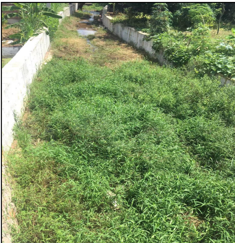
护岸工程现状
