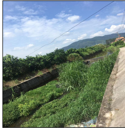
护岸工程现状
