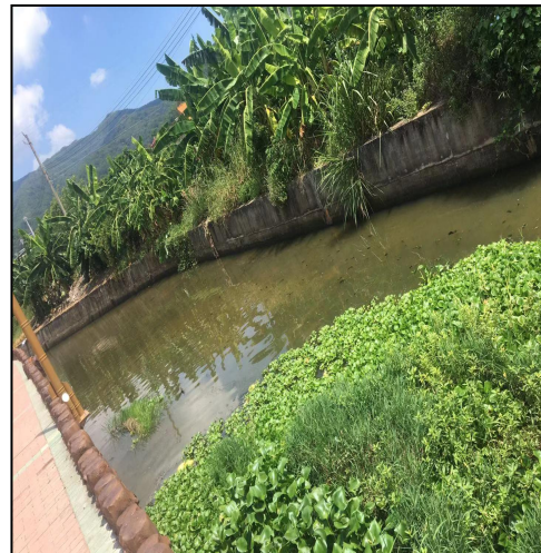
护岸工程现状
