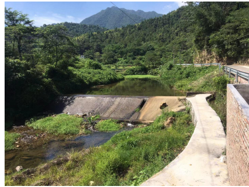
护岸工程现状
