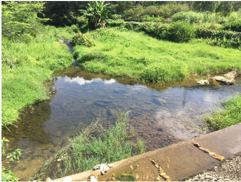
护岸工程现状
