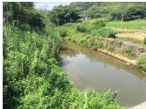
护岸工程现状
