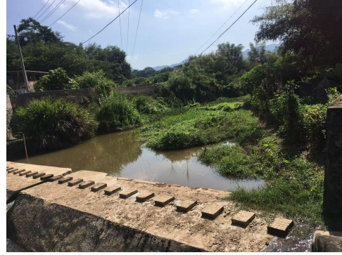
护岸工程现状
