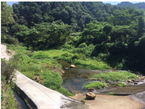
护岸工程现状
