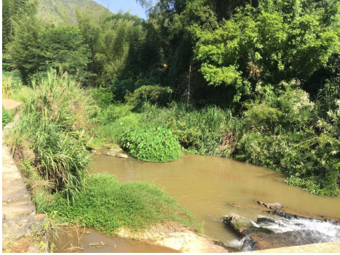
护岸工程现状
