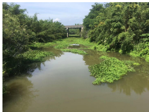
河道生态现状
