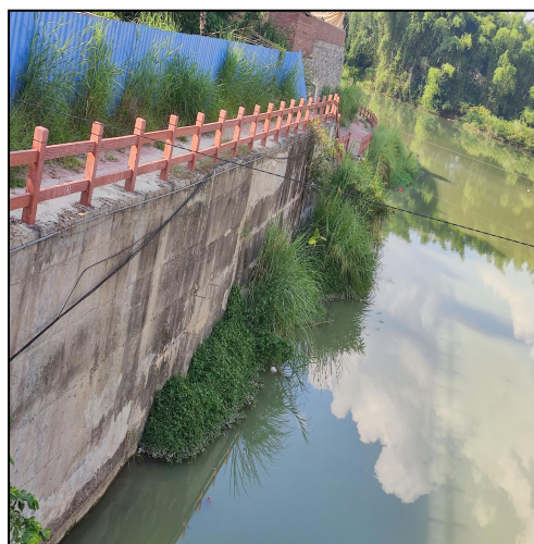
护岸工程现状
