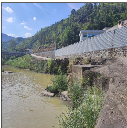
护岸工程现状
