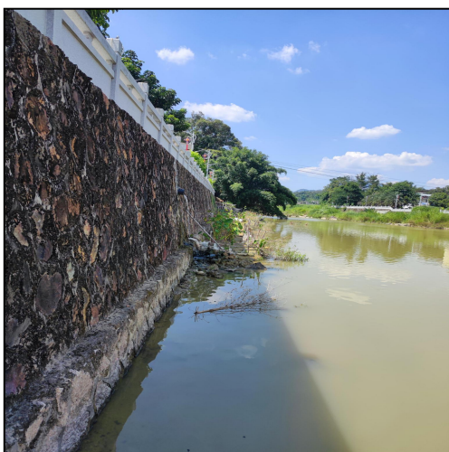
护岸工程现状
