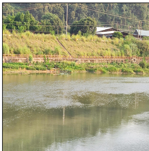
护岸工程现状
