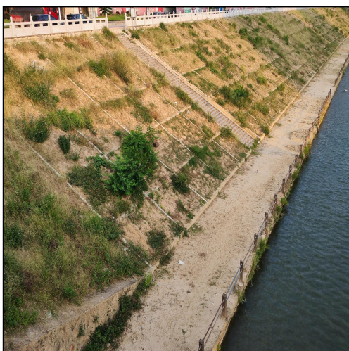
护岸工程现状
