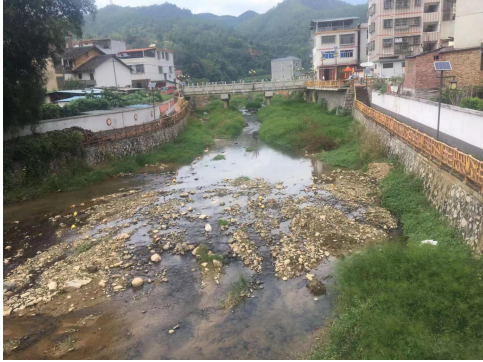
护岸工程现状
