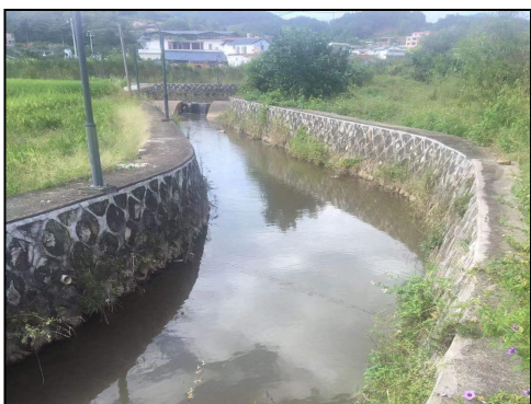
护岸工程现状
