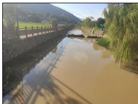
护岸工程现状
