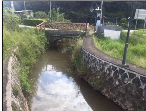
护岸工程现状
