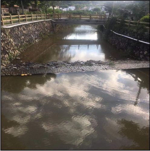
护岸工程现状
