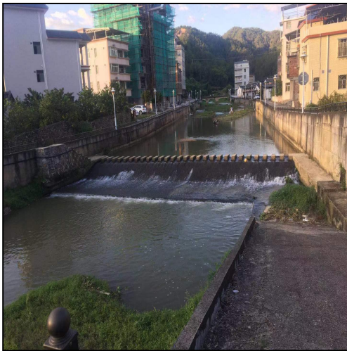
河道生态现状
