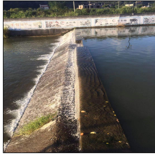
河道生态现状
