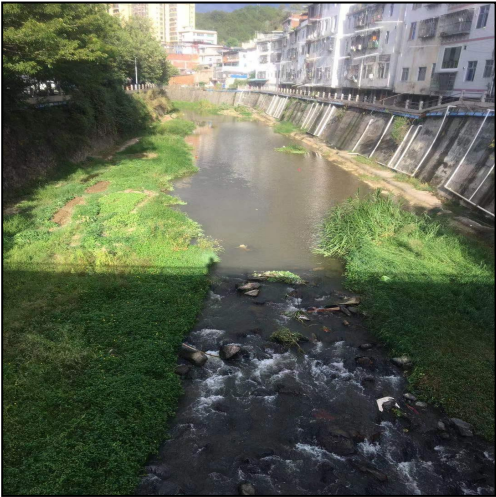
护岸工程现状
