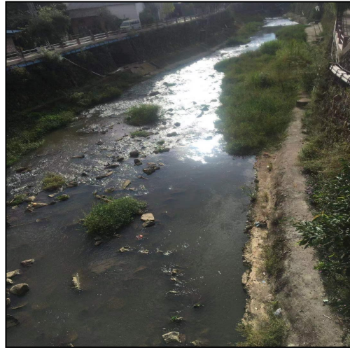
护岸工程现状
