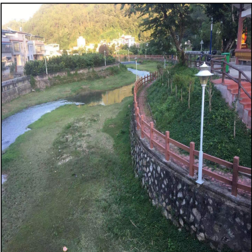
护岸工程现状
