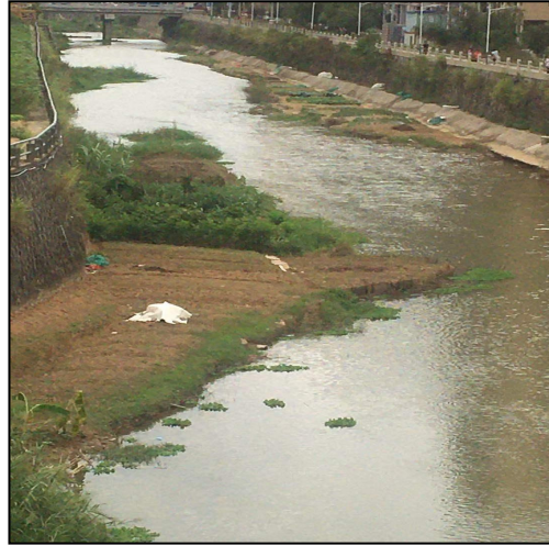
护岸工程现状
