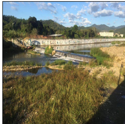
河道生态现状
