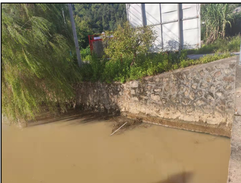
护岸工程现状
