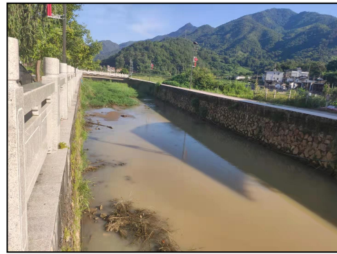
护岸工程现状
