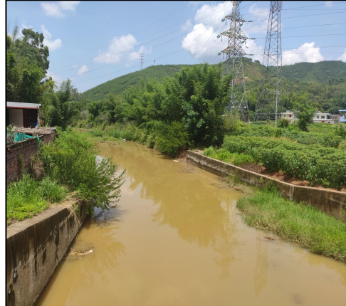
护岸工程现状
