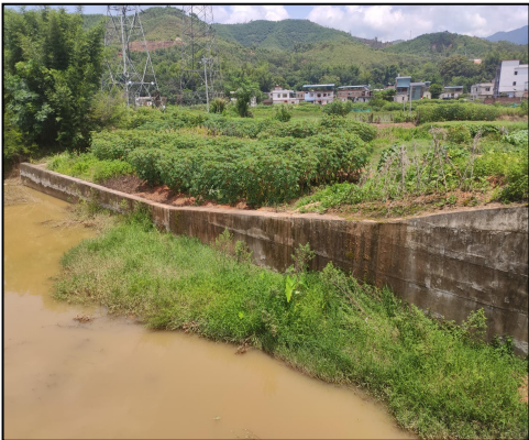
护岸工程现状
