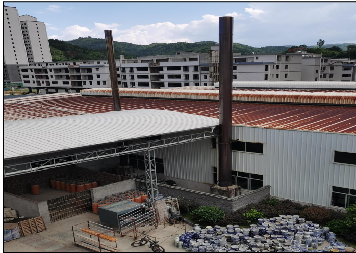
炉窑废气排气筒*2
