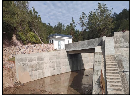
溢洪道进口段
