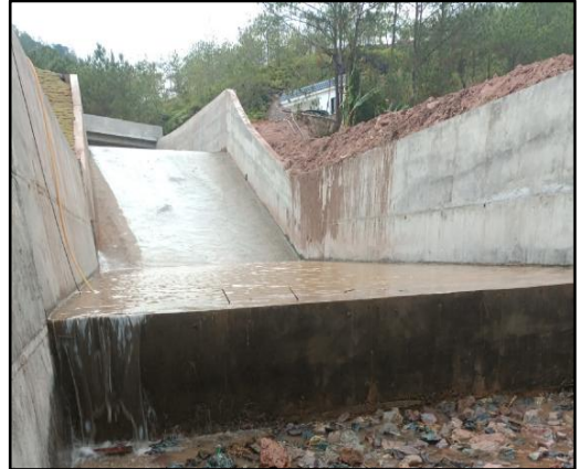
溢洪道消力池
