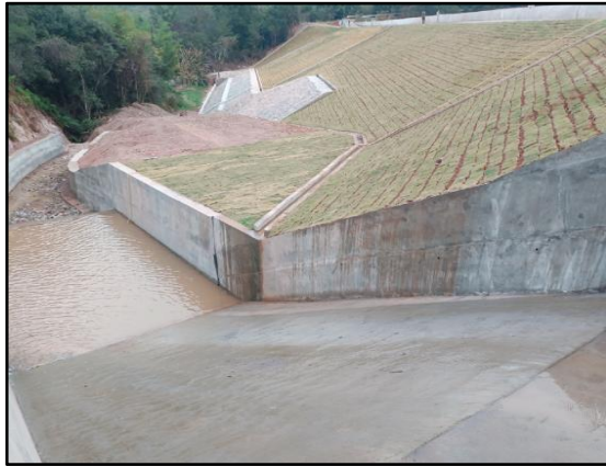
溢洪道泄槽段
