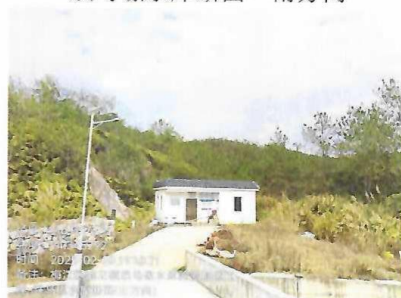
跌马礮水库断面—北方向
