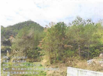
跌马礮水库断面—西方向
