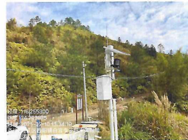
李子坑水库断面—北方向
