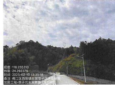
李子坑水库断面—南方向
