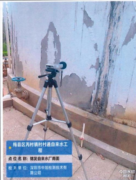
锦发自来水厂厂界南面 1m 处 N2
