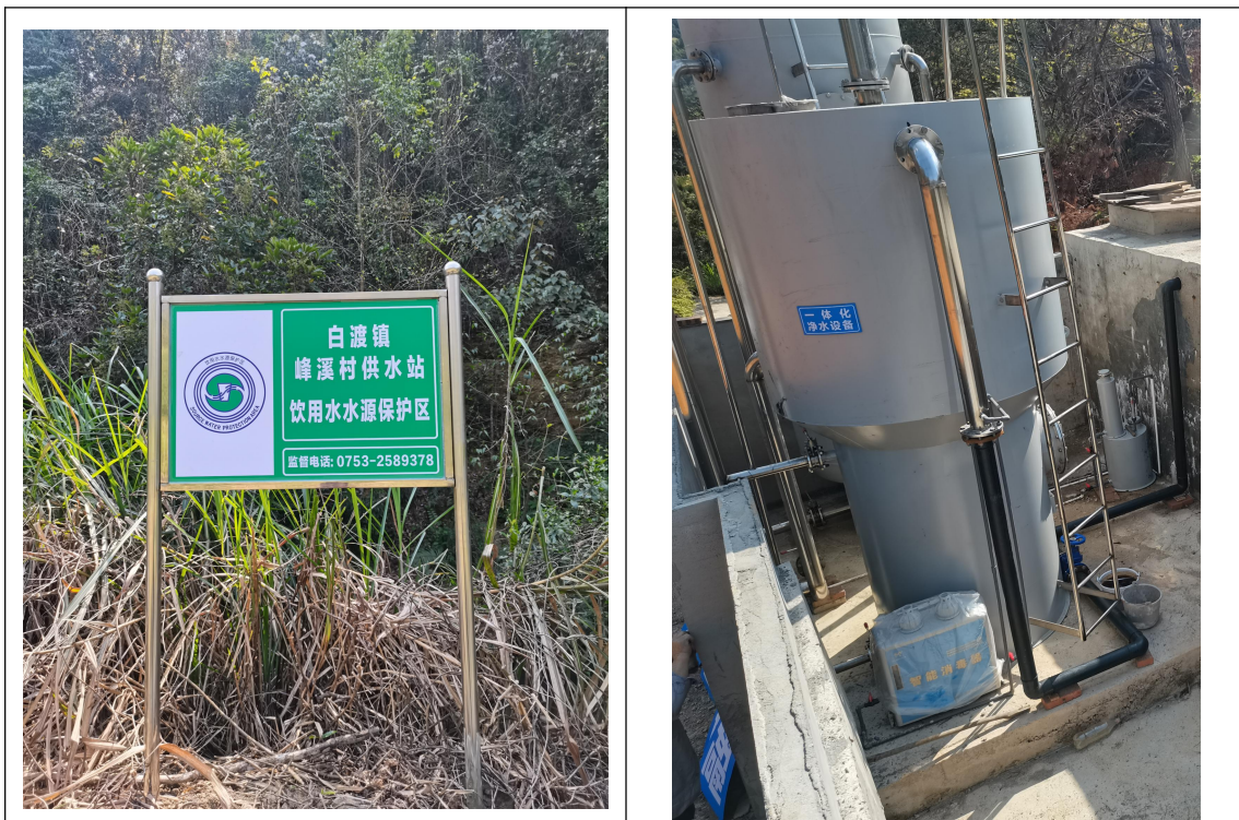
峰溪村供水站
